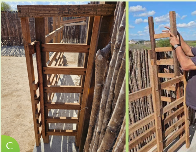
Figura 17. Adequação de instalações para o manejo sanitário dos pequenos ruminantes. (A) Construção de um corredor de passagem com duas pequenas porteiras em curral já existente na propriedade como forma de facilitar a contenção dos animais. (B e C) Brete, construído com material simples, para facilitar a contenção e avaliação dos animais.
